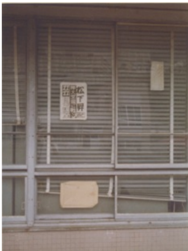
ベランダ側から見た研究室の窓
